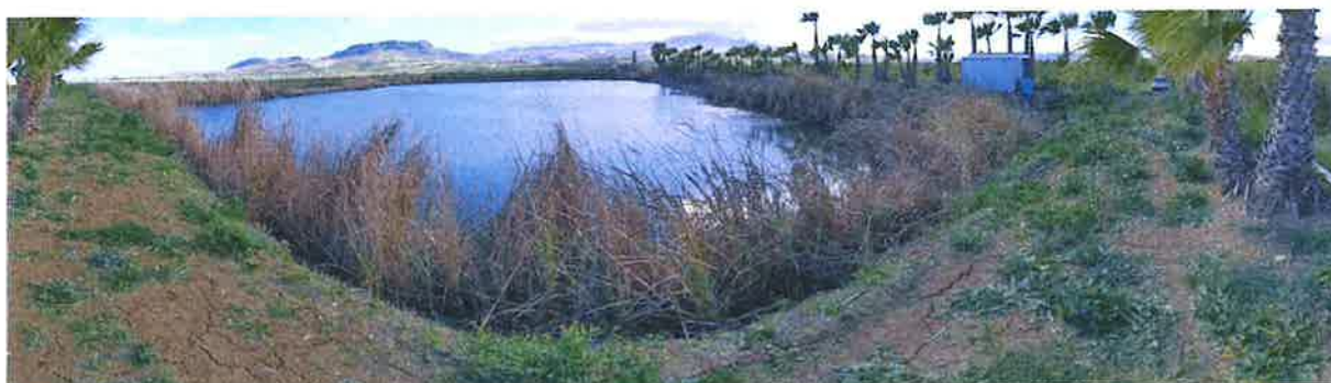
Figura 6 Stato di fatto Invaso 1, bacino che verrà utilizzato per il reintegro dell'acqua.
