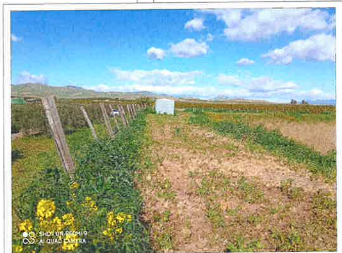
Particolare recinzione Invaso 2
