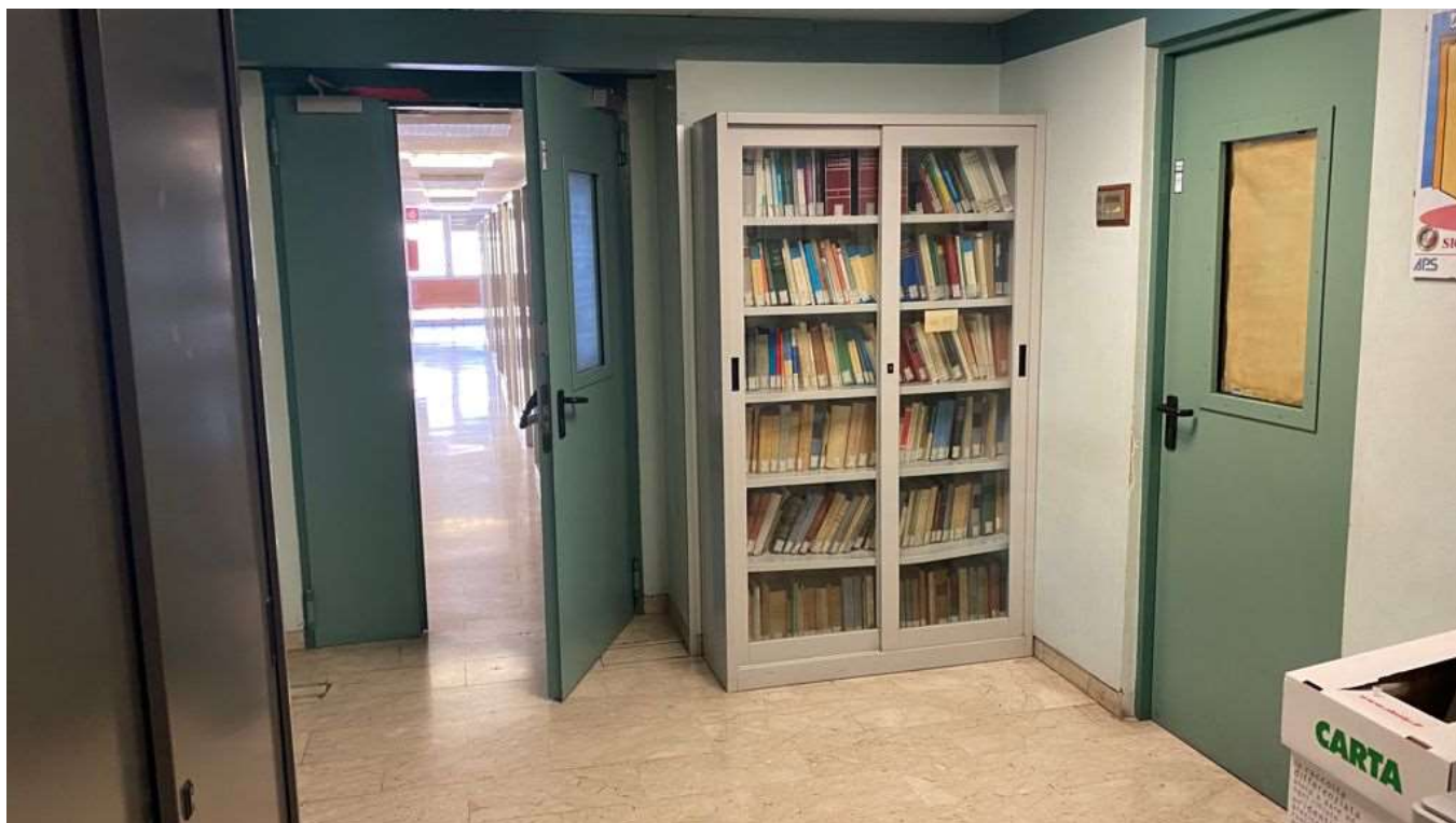
Foto n. 11: piano tipo, disimpegno comune (accesso agli studi)
