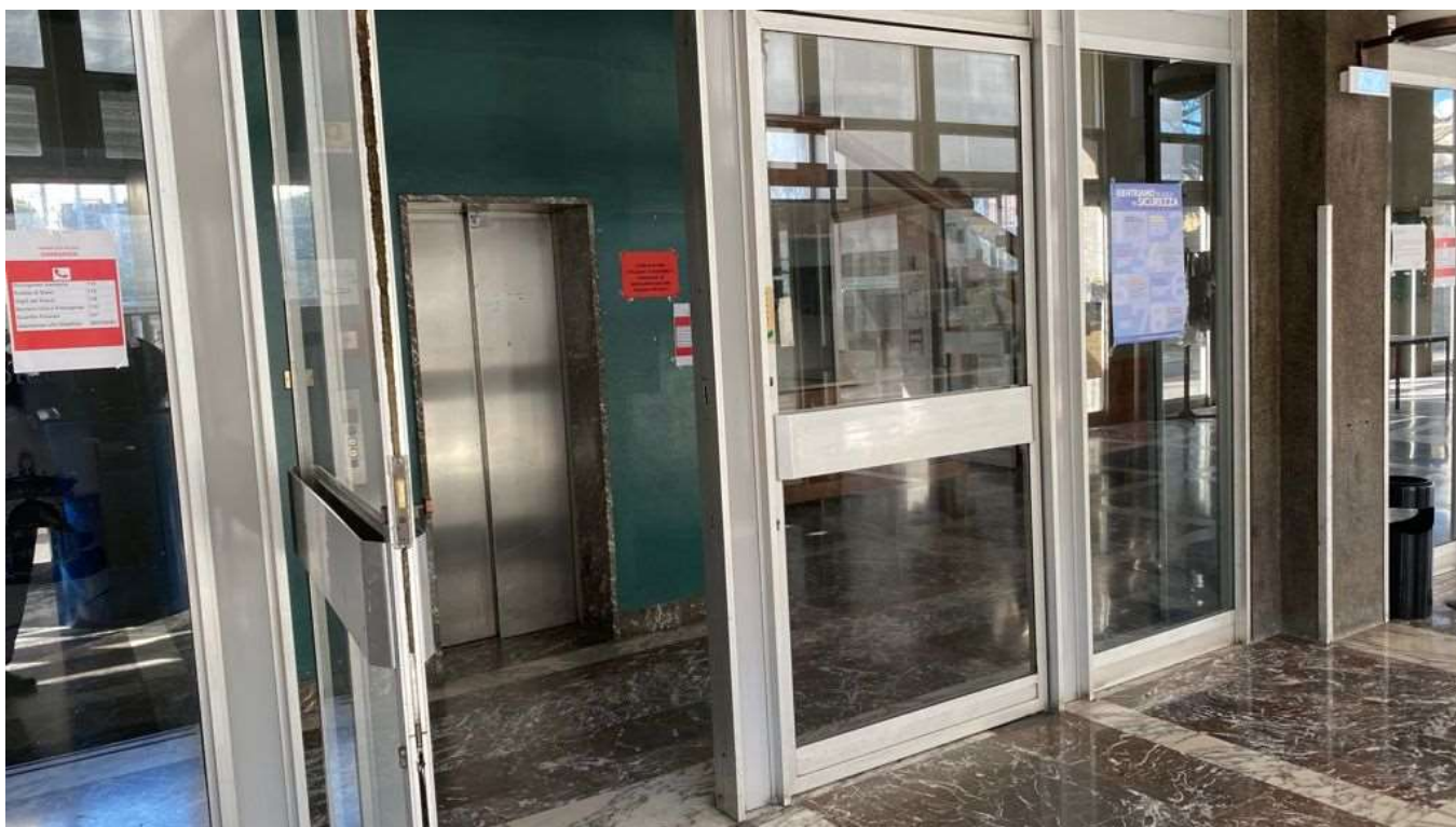
Foto n. 4: hall piano terra, accesso scale/ascensore
