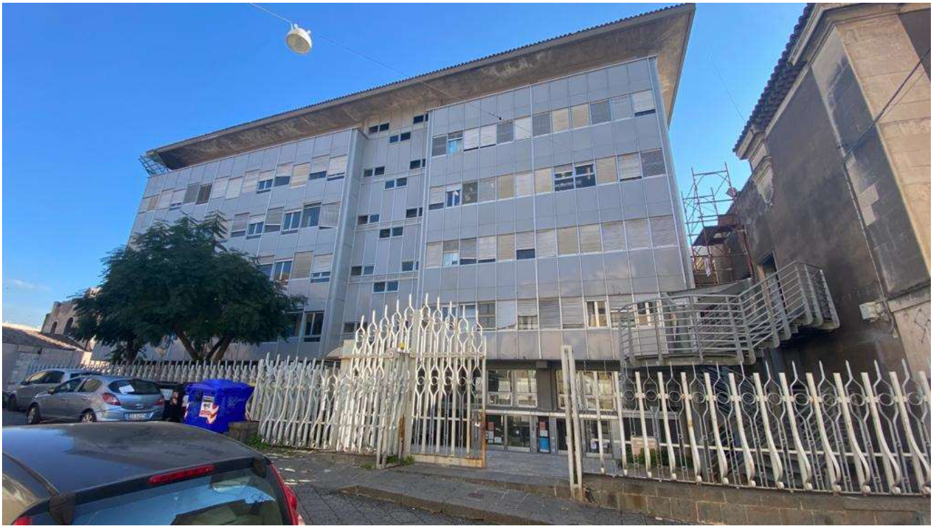
Foto n. 1: vista dell'edificio da via Gallo
