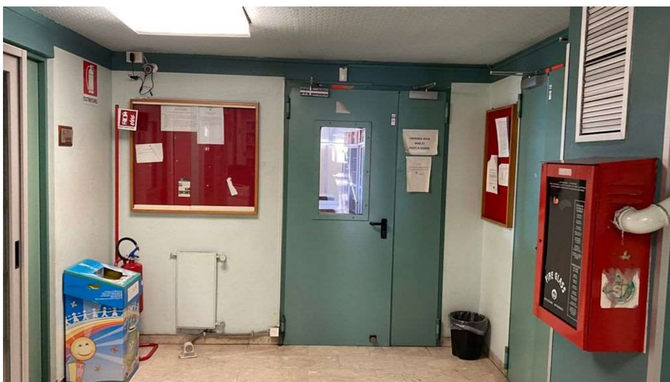
Foto n. 12: piano tipo, disimpegno comune (accesso agli studi)
