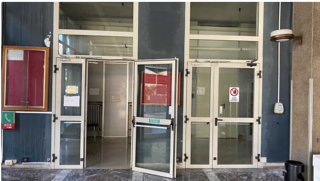
Foto n. 3: hall piano terra. accesso aule
