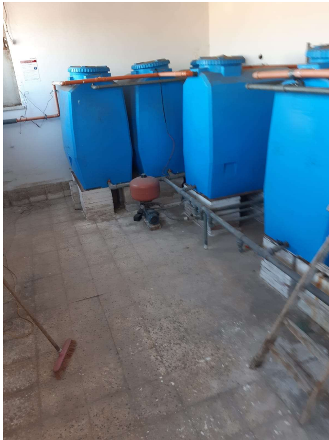
Foto n. 17: locali sotto tetto, vasche accumulo acqua
