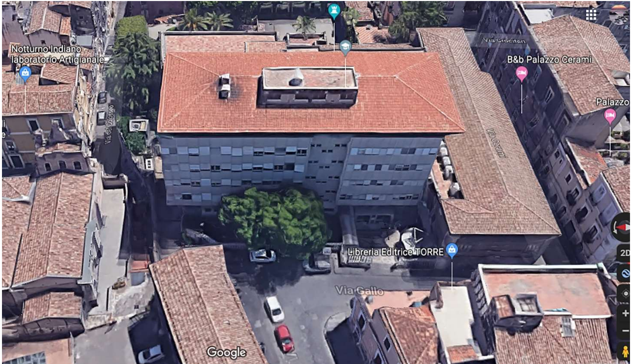
Fig. 3 _Stato di fatto_ fronte su via Gallo
