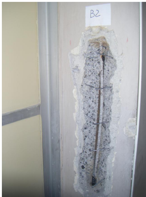
Barra di armatura saldata alla barra esistente prima del prelievo
