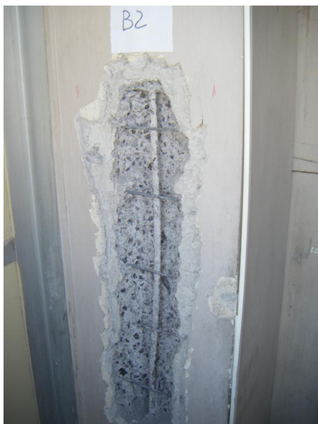
Barra di armatura esistente prima del prelievo
