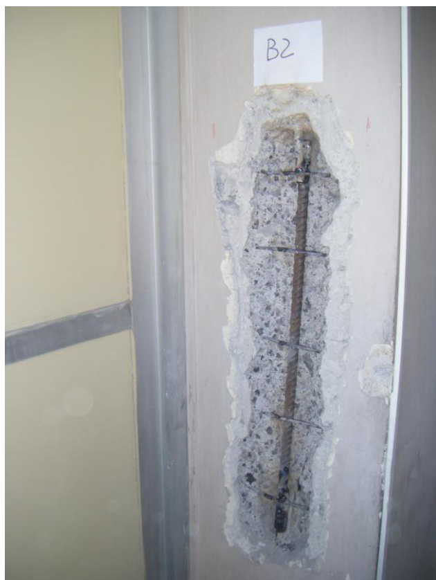
Barra di armatura saldata alla barra esistente dopo del prelievo
