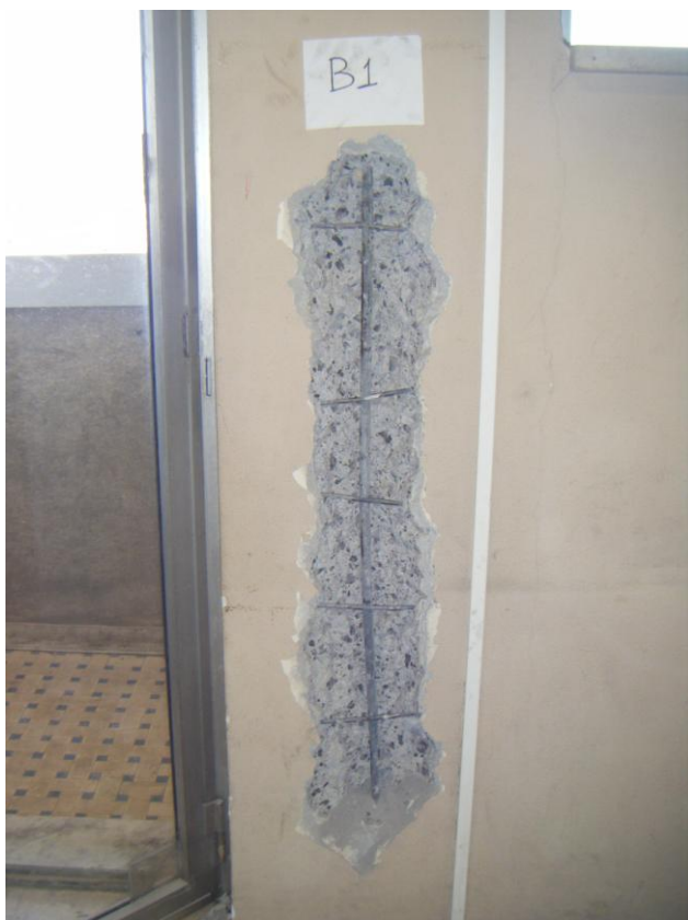
Barra di armatura esistente prima del prelievo
