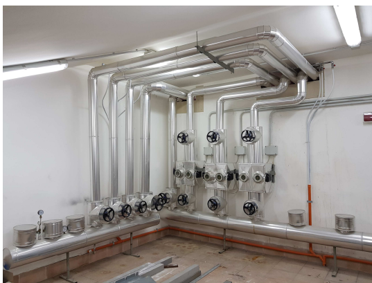
Locale tecnico al piano quarto
