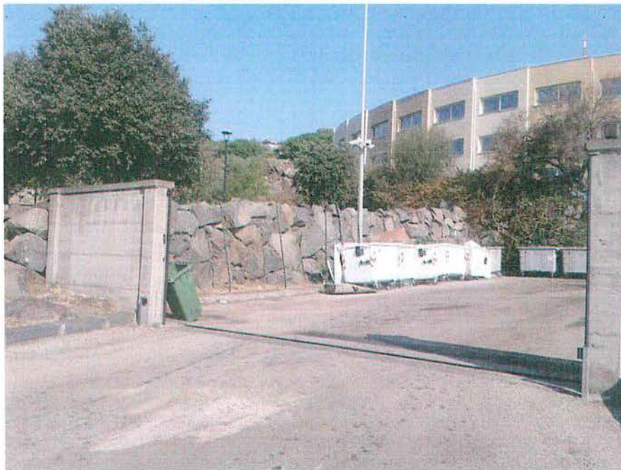
Foto 4 - Sito di progetto della nuova vasca in cemento armato visto da est
