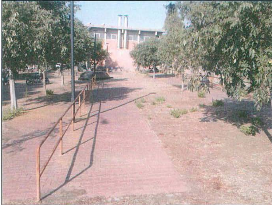
Foto 1 – Sito di progetto della nuova vasca in cemento armato visto da est.
